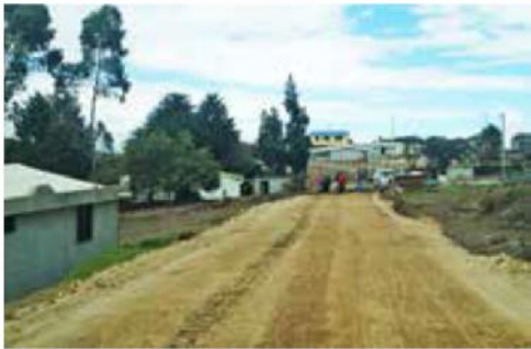
Mejoramiento de la vía La Pacífica
